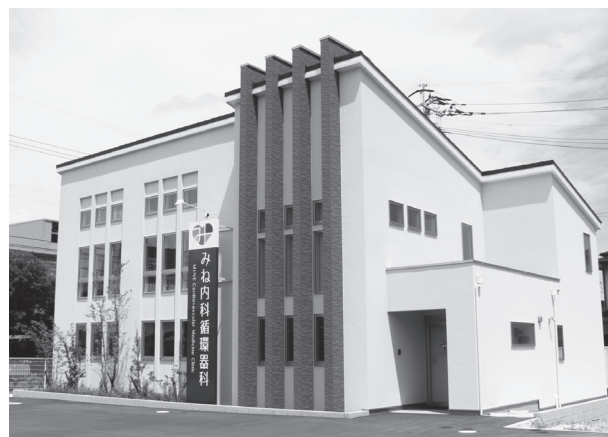
写真 1 ◆クリニックの外観
